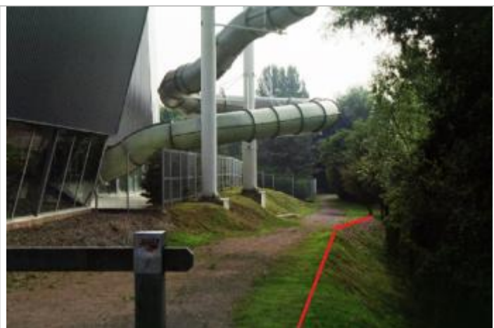
L'eau a atteint la limite des berges-digues (Photo: BCEOM)
