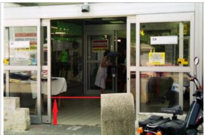
Devanture du magasin, le trait rouge indiquant le niveau de l'eau (Photo: BCEOM)
