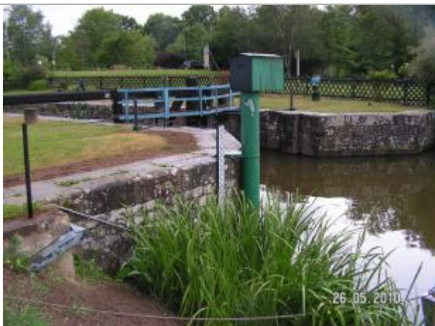
Echelle limnimétrique sur le bajoyer amont de l'écluse de Robinson à Saint-Grégoire
