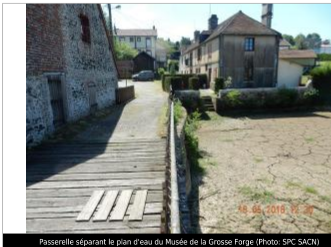
Passerelle séparant le plan d'eau du Musée de la Grosse Forge (Photo: SPC SACN)
