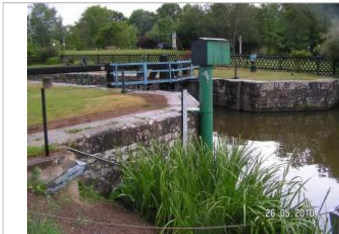
Echelle limnimétrique sur le bajoyer amont de l'écluse Robinson de Saint-Grégoire
