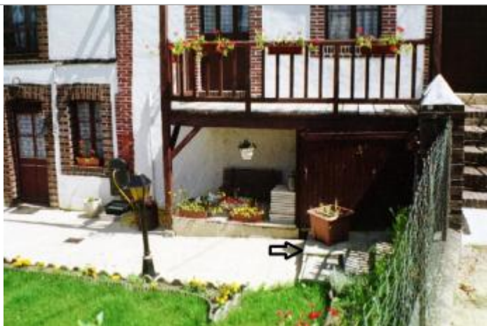
L'eau est arrivée jusqu'à la première marche du portillon (Photo: BCEOM)
