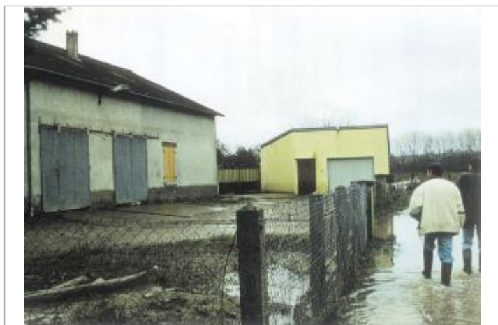
Le niveau a presque atteint le bas de la fenêtre, visible avec la marque d'inondation (Photos: BCEOM)
