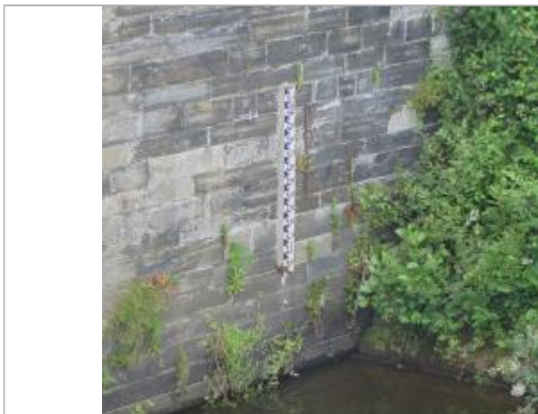
Echelle limnimétrique sur le pont de la route de La Planche à l'aval de l'écluse d'Apigné
