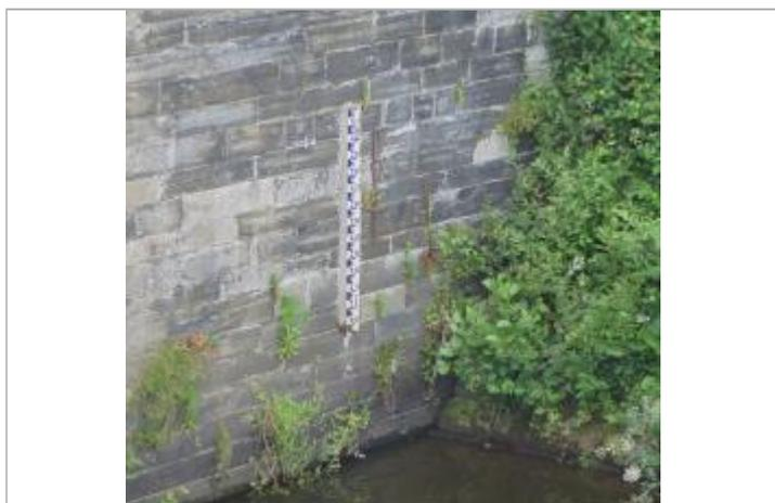
Echelle limnimétrique sur le pont de la route de La Planche à l'aval de l'écluse d'Apigné
