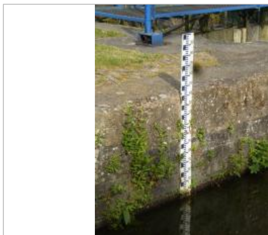
Echelle limnimétrique sur le bajoyer amont de l'écluse d'Apigné à Rennes
