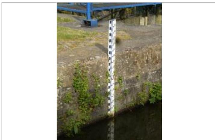
Echelle limnimétrique sur le bajoyer amont de l'écluse d'Apigné à Rennes
