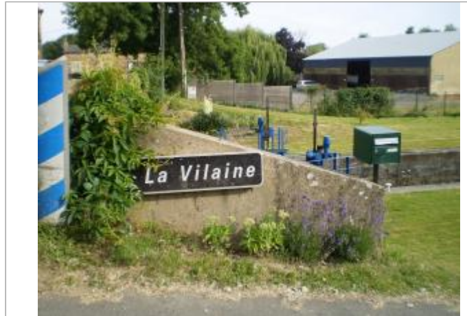
Site de l'écluse d'Apigné à Rennes
