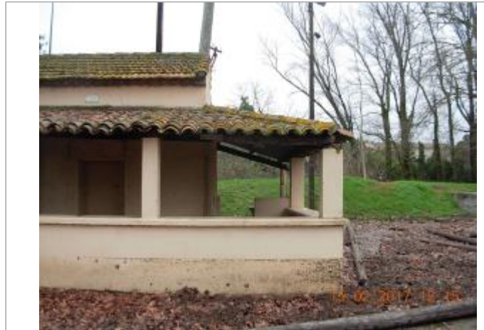
Mur extérieur de la terrasse couverte du local près du jeux de boule
