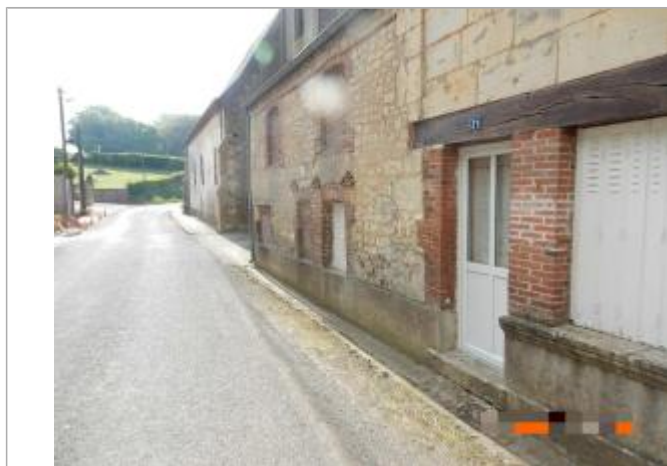
Niveau d'eau a atteint le haut de la marche du seuil (Photo: SPC SACN)
