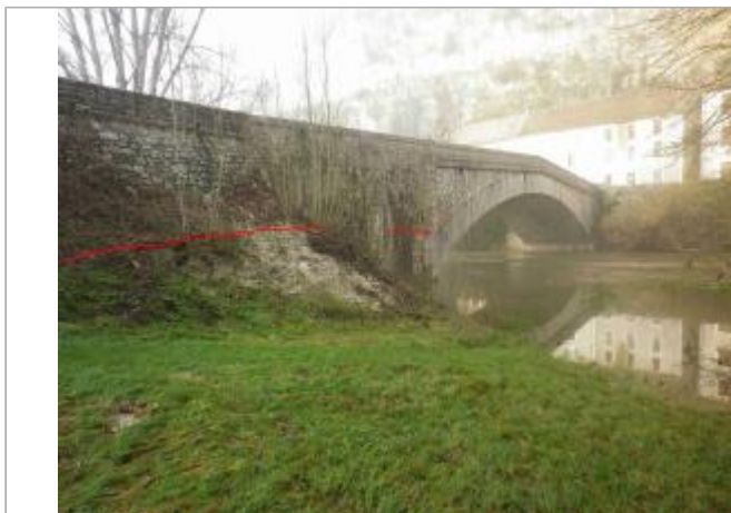
Vue du site - Auteur : GEOSPHAIR
