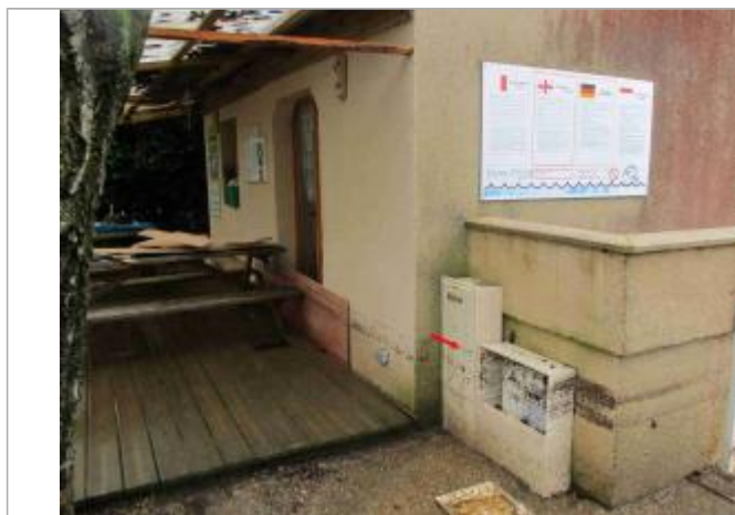
Vue de la laisse d'inondation - Auteur : DDT46
