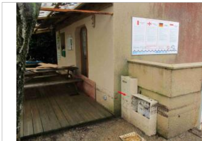
Vue de la laisse d'inondation - Auteur : DDT46
