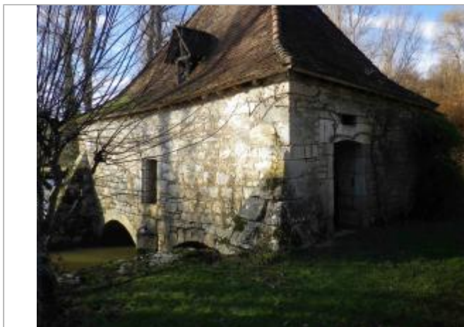
Vue du site - Auteur : GEOSPHAIR
