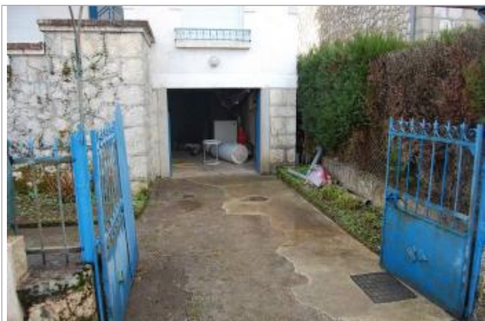
Vue de la laisse d'inondation - Auteur : GEOSPHAIR
