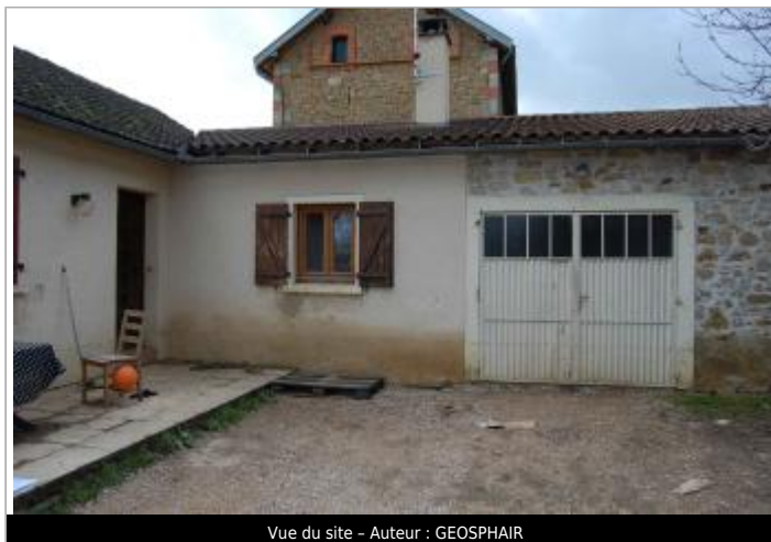
Vue du site - Auteur : GEOSPHAIR
