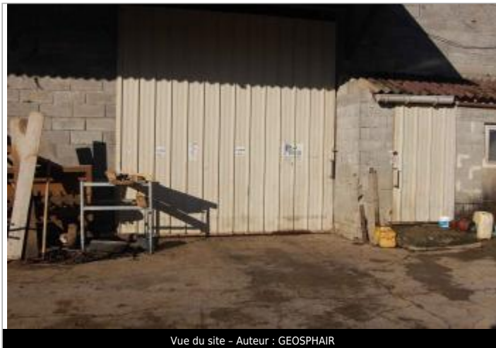
Vue du site - Auteur : GEOSPHAIR
