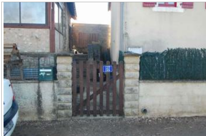
Vue du site - Auteur : GEOSPHAIR
