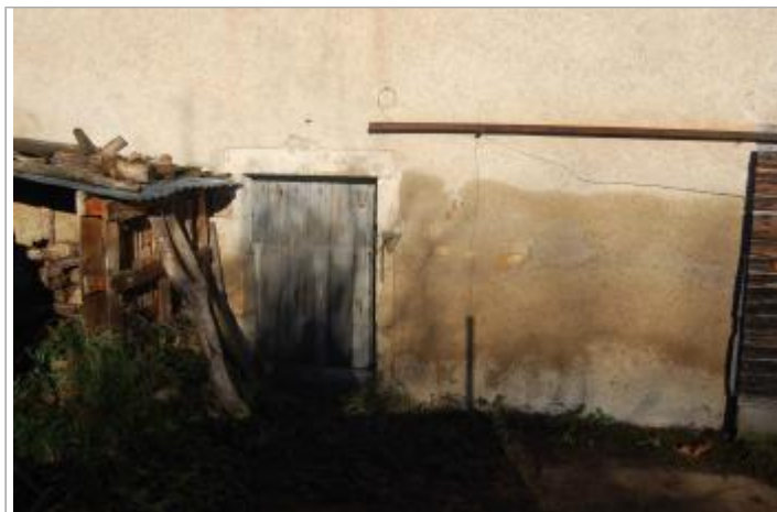
Vue du site - Auteur : GEOSPHAIR
