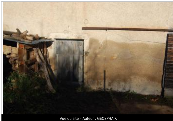
Vue du site - Auteur : GEOSPHAIR
