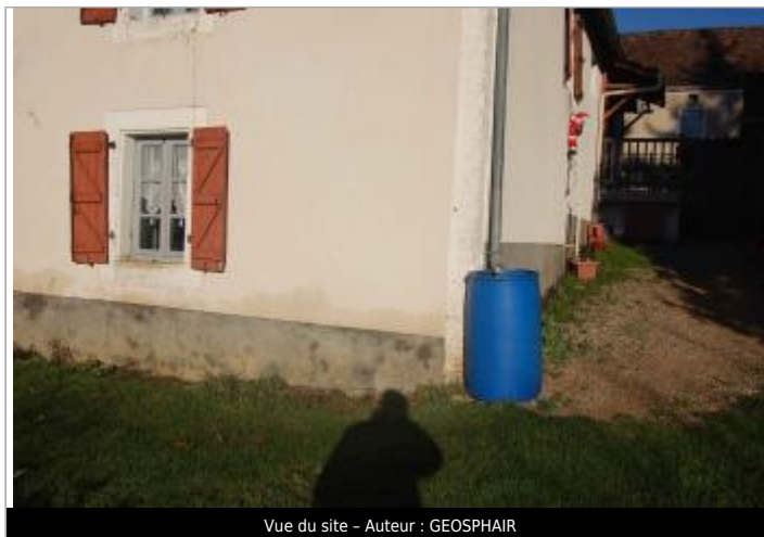
Vue du site - Auteur : GEOSPHAIR
