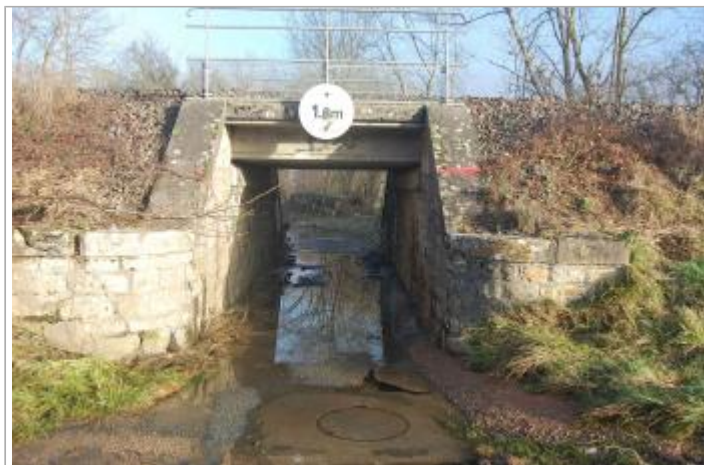
Vue du site - Auteur : GEOSPHAIR
