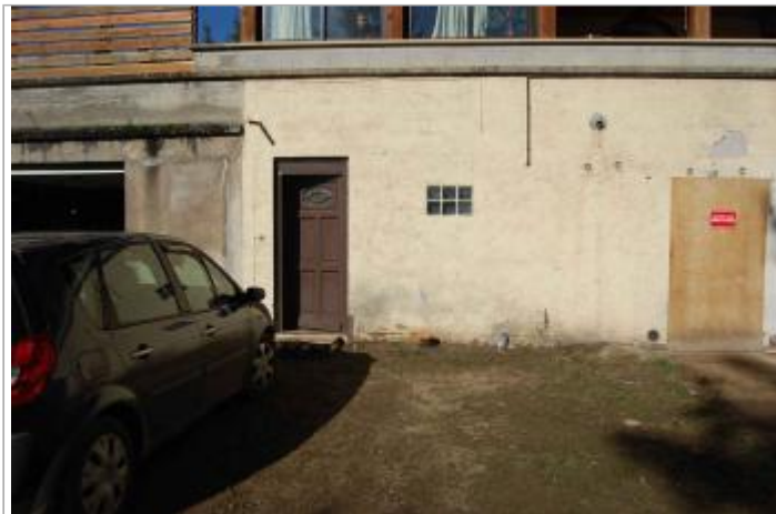
Vue du site - Auteur : GEOSPHAIR
