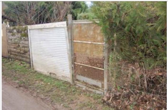
Vue du site - Auteur : GEOSPHAIR
