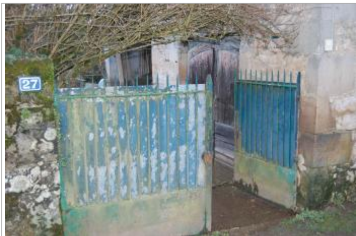
Vue du site - Auteur : GEOSPHAIR
