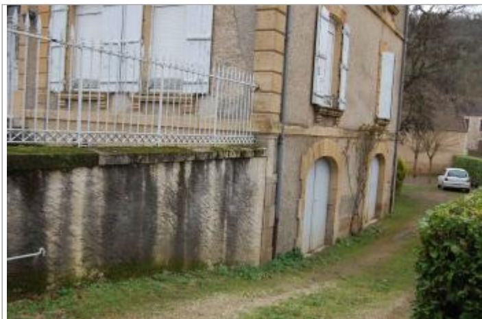
Vue du site - Auteur : GEOSPHAIR
