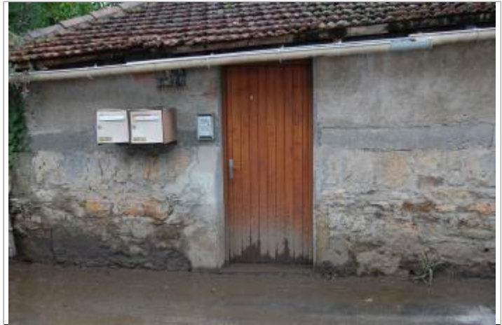
Vue du site - Auteur : GEOSPHAIR
