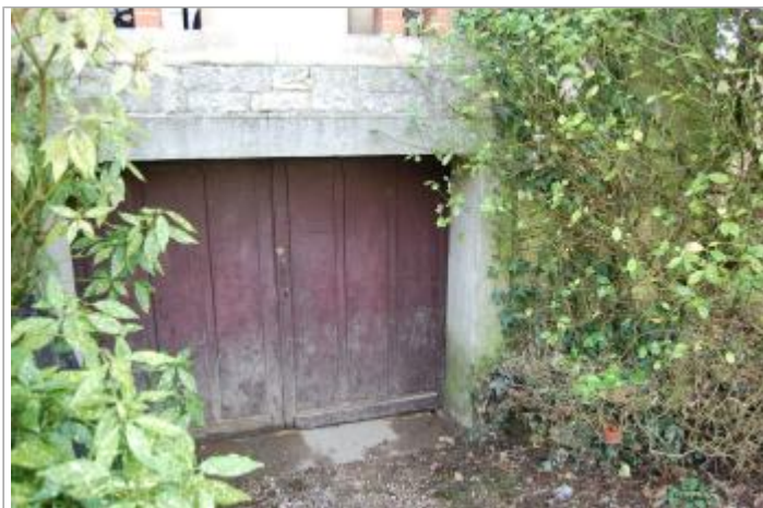
Vue du site - Auteur : GEOSPHAIR
