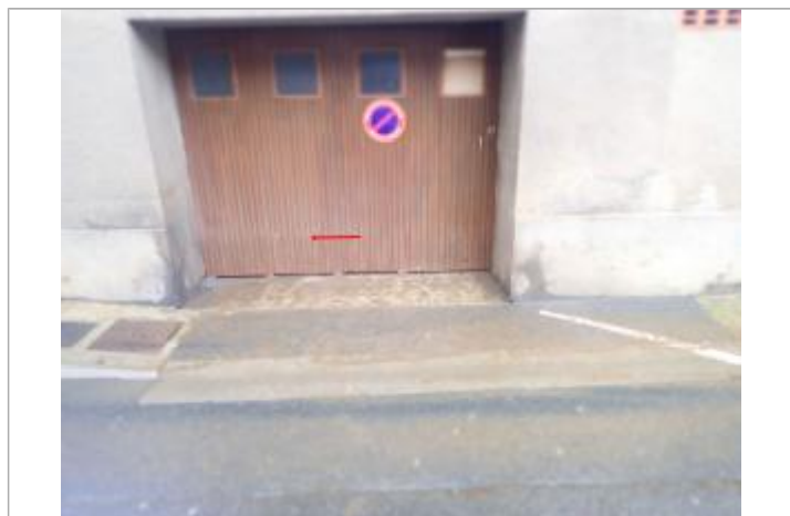
Vue de la laisse d'inondation - Auteur : Syndicat du Bassin de la Rance et du Célé
