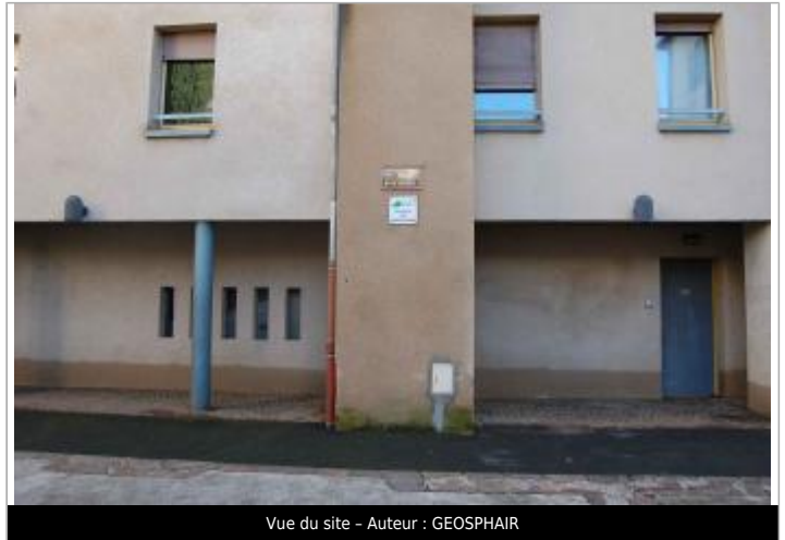
Vue du site - Auteur : GEOSPHAIR
