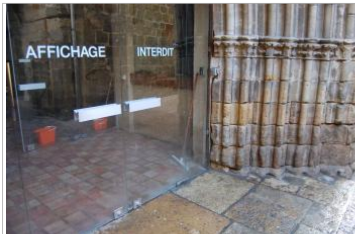
Vue du site - Auteur : GEOSPHAIR
