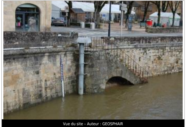
Vue du site - Auteur : GEOSPHAIR
