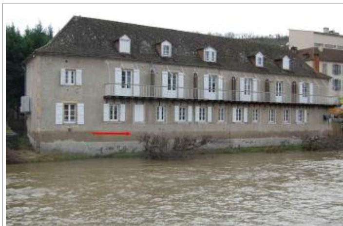
Vue du site - Auteur : GEOSPHAIR
