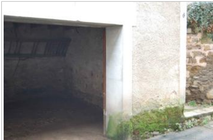
Vue du site - Auteur : GEOSPHAIR
