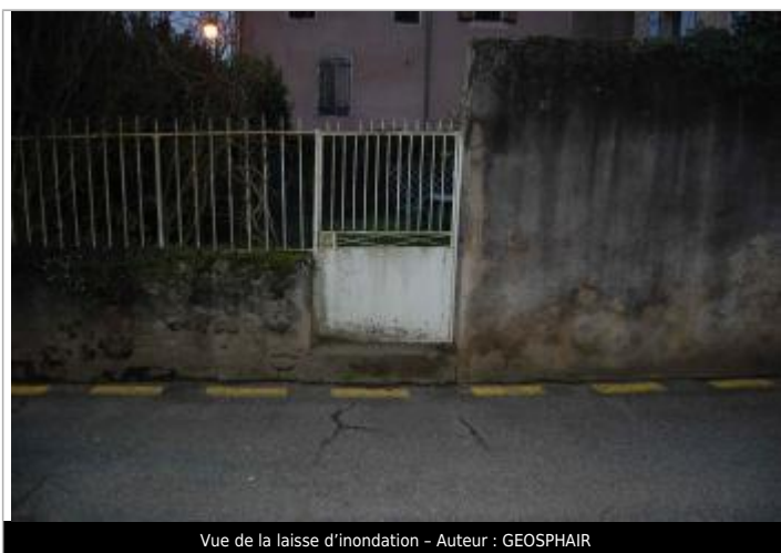
Vue de la laisse d'inondation - Auteur : GEOSPHAIR
