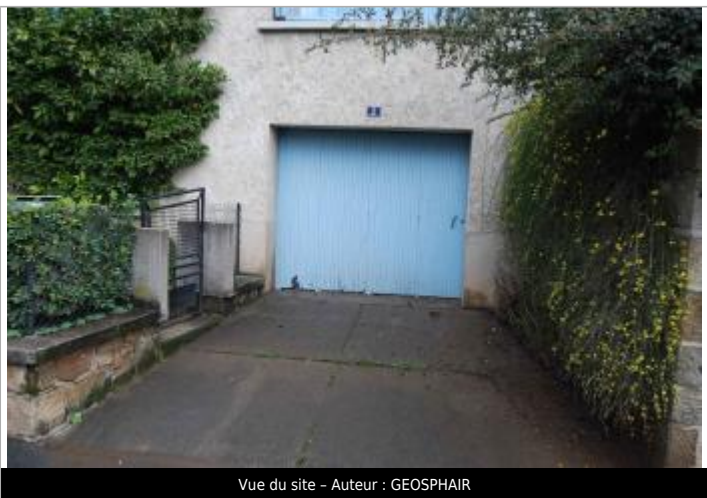
Vue du site - Auteur : GEOSPHAIR
