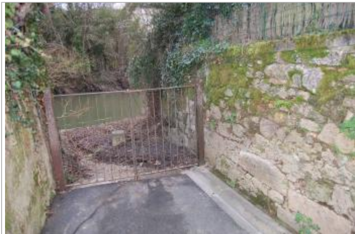
Vue du site - Auteur : GEOSPHAIR
