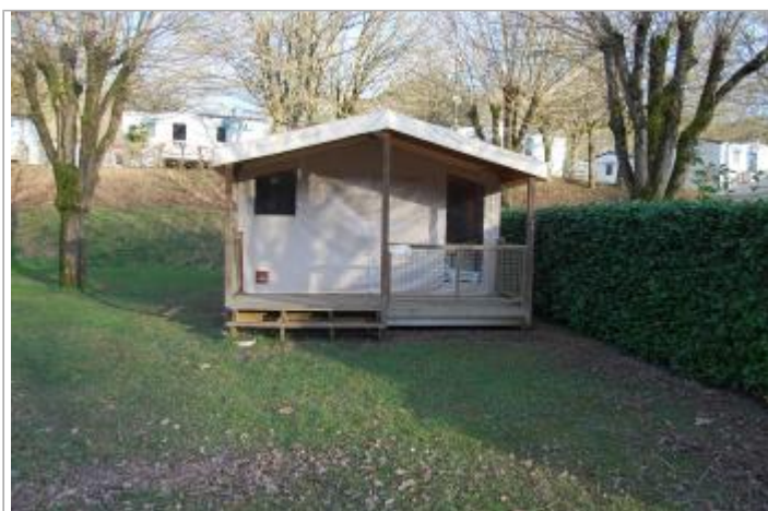
Vue du site - Auteur : GEOSPHAIR
