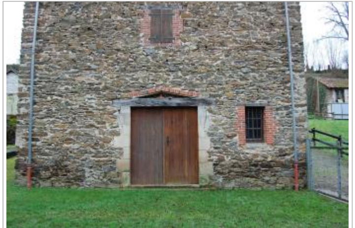
Vue du site - Auteur : GEOSPHAIR
