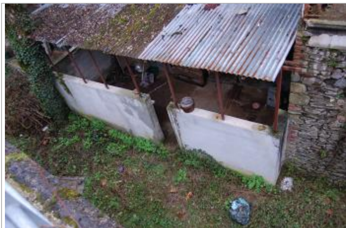
Vue du site - Auteur : GEOSPHAIR
