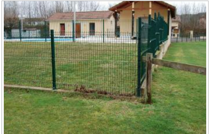
Vue du site - Auteur : GEOSPHAIR
