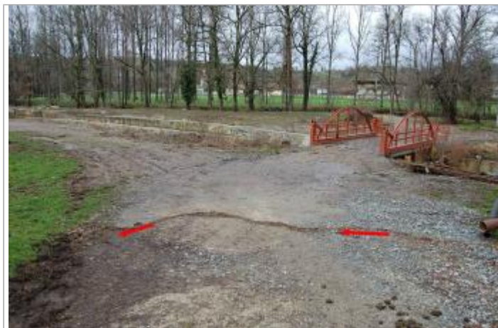
Vue du site - Auteur : GEOSPHAIR
