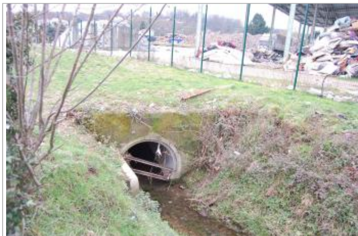
Vue du site - Auteur : GEOSPHAIR
