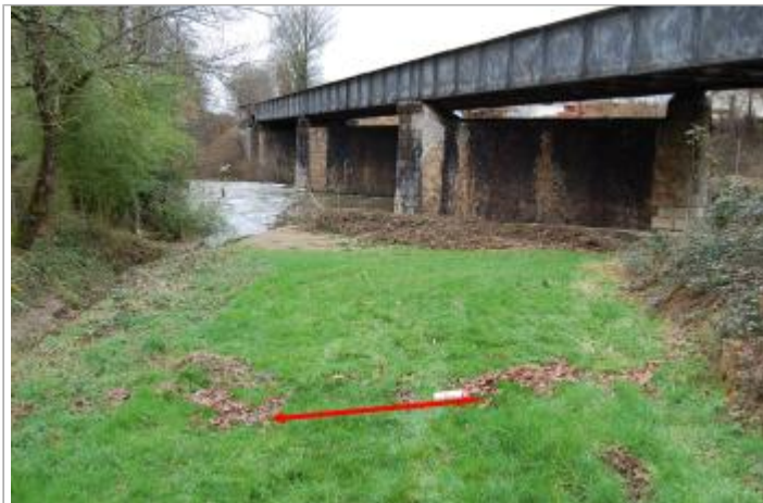
Vue du site - Auteur : GEOSPHAIR
