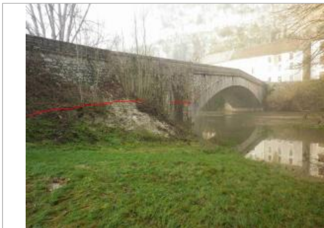
Vue du site - Auteur : GEOSPHAIR
