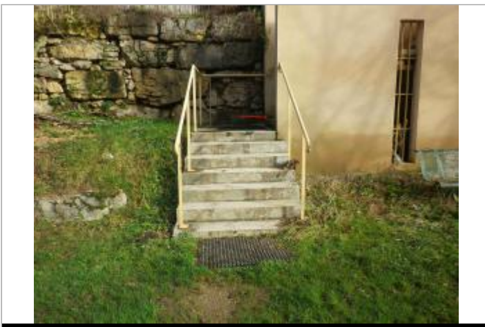
Vue du site - Auteur : GEOSPHAIR
