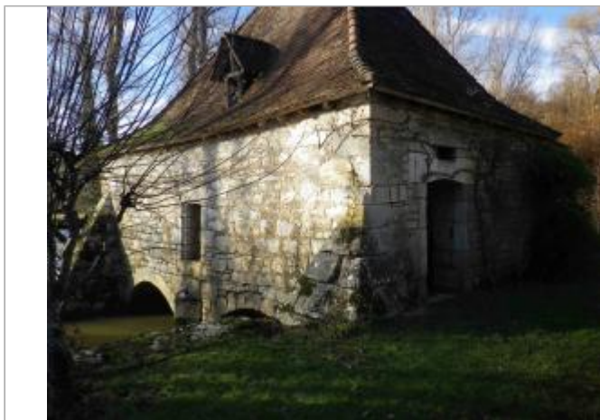
Vue du site - Auteur : GEOSPHAIR
