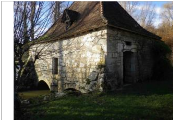
Vue du site - Auteur : GEOSPHAIR
