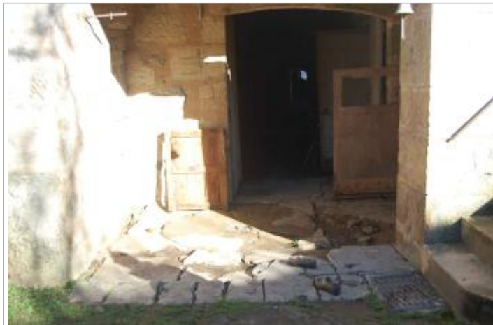
Vue du site - Auteur : GEOSPHAIR
